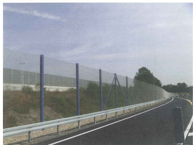
Bild 5 Beispiel einer Fledermausüberflughilfe an der A44 bei Witten mit 25*25 Maschendrahtgeflecht.
