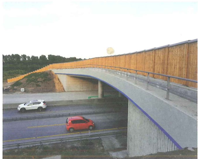
Bild 1 Irritationswand auf einer Querung der A7 bei Brokenlande.
