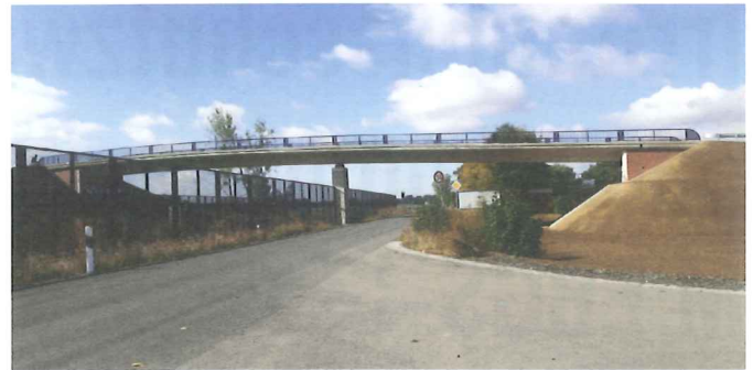
Bild 3 Kollisionsschutzwand an der B6 bei Kobbensen mit 30*30 Welldrahtgitter im Stahlrahmen
